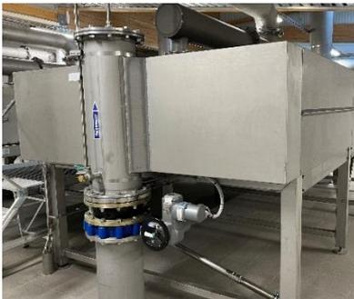
Nach der Vermischung befindet sich zu viel freie Kohlensäure im Wasser. Um das natürliche Gleichgewicht (Kalk- Kohlensäure- Gleichgewicht) wieder herzustellen, wird dem Wasser gereinigte und gefilterte Luft zugegeben. Die gereinigte Luft wird feinperlig in den Wasserstrom geleitet und so die überschüssige Kohlensäure ausgestrippt.
