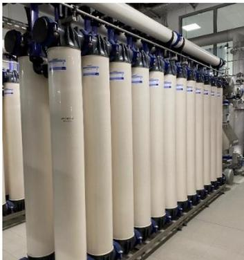
In der Ultrafiltration wird das Rohwasser durch feinste Membrane (0,02  $\mu\text{m}$ ) geleitet. Diese Membrane halten alle Partikel, sowie Trübstoffe aus dem Rohwasser zurück. Zudem erfolgt in dieser Aufbereitungsstufe die zuverlässige Entfernung von Bakterien und Viren aus dem Wasser.
