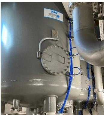
Die Aktivkohlefiltration dient als zusätzliche Schutzstufe zur Ultrafiltration. Hier werden die im Rohwasser enthaltenen Spurenstoffe, wie z.B. Pflanzenschutzmittel, deren Metaboliten, oder Medikamentenrückstände weitestgehend aus dem Trinkwasser entfernt.
