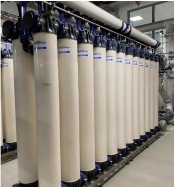
In der Ultrafiltration wird das Rohwasser durch feinste Membrane (0,02 µm) geleitet. Diese Membrane halten alle Partikel, sowie Trübstoffe aus dem Rohwasser zurück. Zudem erfolgt in dieser Aufbereitungsstufe die zuverlässige Entfernung von Bakterien und Viren aus dem Wasser.
