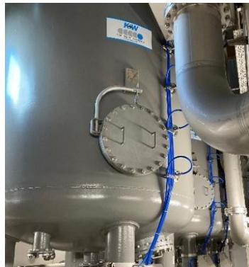
Die Aktivkohlefiltration dient als zusätzliche Schutzstufe zur Ultrafiltration. Hier werden die im Rohwasser enthaltenen Spurenstoffe, wie z.B. Pflanzenschutzmittel, deren Metaboliten, oder Medikamentenrückstände weitestgehend aus dem Trinkwasser entfernt.
